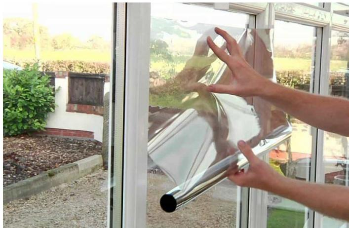
Le pellicole solari sono l'alternativa ideale alla climatizzazione e permettono di migliorare l'isolamento.
